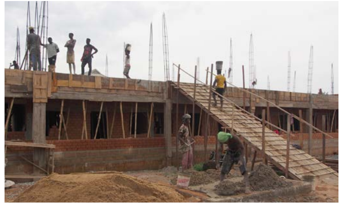
Das Erdgeschoss des Studentenwohnheims der MOCTECH entsteht
