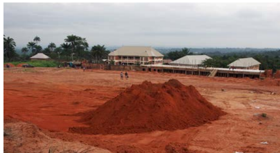
Blick auf das Projektgelände mit den in Betrieb befindlichen Schulgebäuden im Hintergrund und der Baustelle für Wohnheim, Küche/Aula und Fussballplatz im Vordergrund
